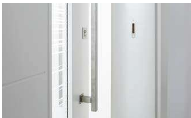
Pendeltür mit Schloss, Schließblech und Stangengriff
