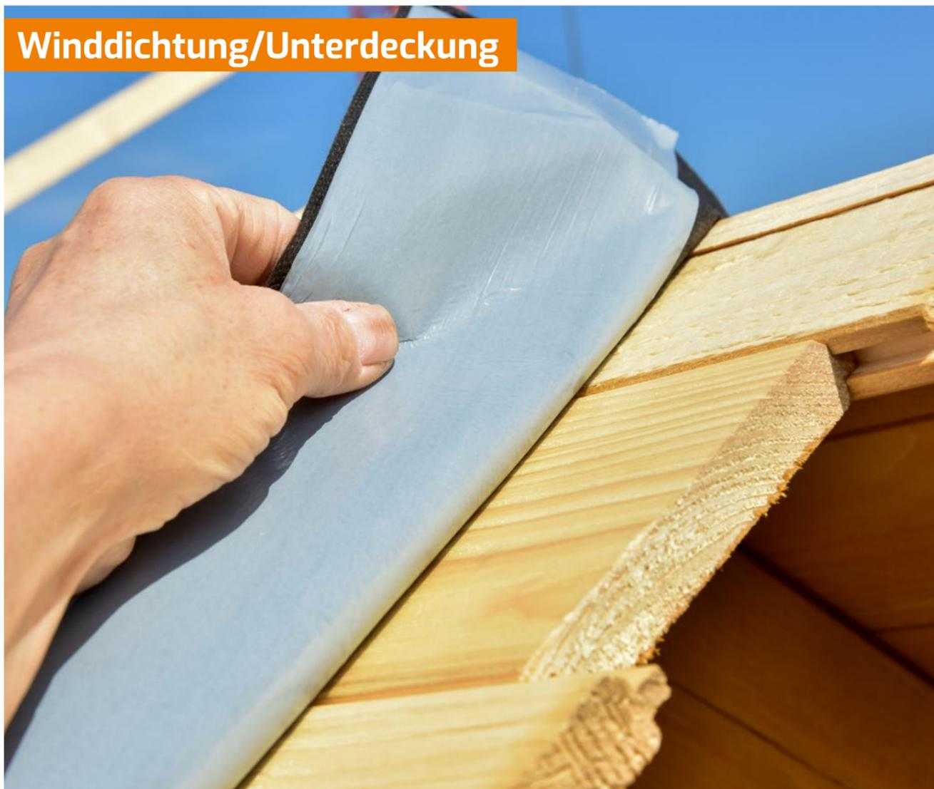
**OMEGA MONO 200 – Unterdachbahn (mit Klebestreifen)** ISOCELL
