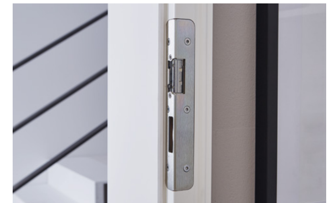
Schließblech mit E-Öffner
