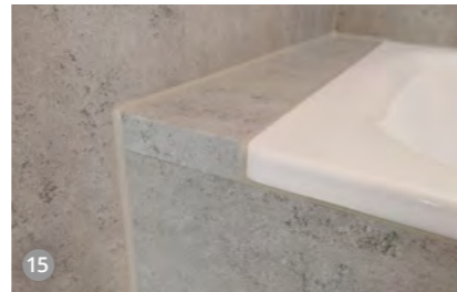
14 Fräskanttechnik* Die Platten können mit einer V-Nutfräse rückseitig mit einer Einkerbung versehen werden, an der die Platte präzise von Hand gebogen werden kann. Dadurch ergibt sich eine geschlossene Außenkante.
