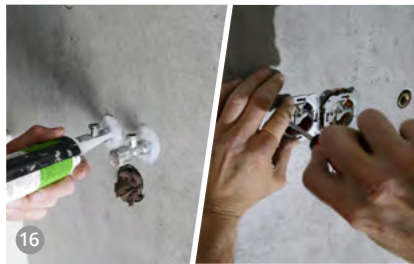
16 Öffnungen mit Silikon ausspritzen und Armaturen montieren
