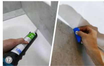
17 Fugen mit Silikon abdichten und Silikon abziehen
