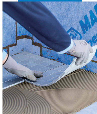
Verlegung von keramischen Fliesen
