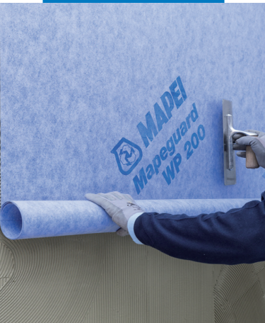
Verlegung von Mapeguard WP 200
