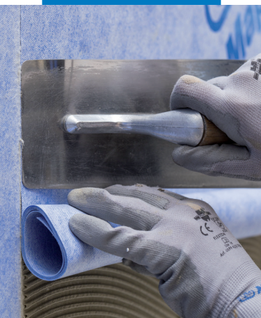
Aufbringen der anschließenden Bahn
