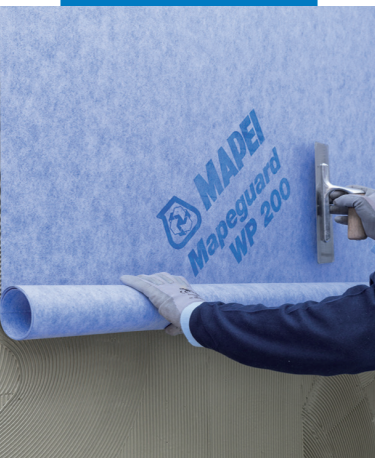
Verlegung von Mapeguard WP 200
