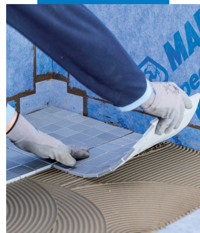
Verlegung von keramischen Fliesen
