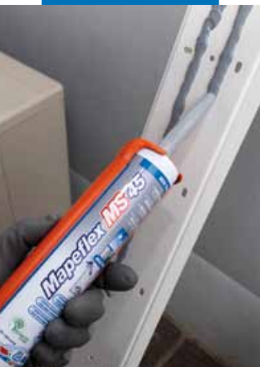
Verklebung von Kunststoff-Profilen im Außenbereich
