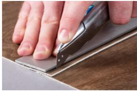
Die überlappend ausgelegten Belagsbahnen (3–5 cm) werden gleichzeitig in einem einzigen Schnitt entlang einer Metallschiene durchgeschnitten (Doppelschnittverfahren).
