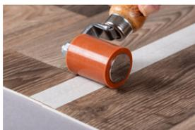
Das Papierklebeband fest auf den PVC-Bodenbelag anpressen, damit keine Kaltschweißpaste unter das Klebeband laufen und die Belagsoberfläche beschädigen kann.
