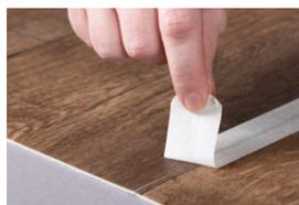
Das Klebeband ca. 10 Minuten nach der Verschweißung schräg nach hinten abziehen. Quellungen des PVC-Belages im Nahtbereich gehen zurück. Die Naht kann nach ca. 60 Minuten begangen werden.
