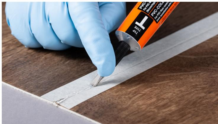
Arbeiten Sie immer mit beiden Händen! Halten Sie die Tube so, dass der Zeigefinger einer Hand auf der T-Düse liegt und die andere Hand die Tube hält sowie die Kaltschweißpaste dosiert.
