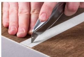
Mit einer scharfen Klinge das Klebeband vorsichtig im Nahtbereich durchtrennen und anschließend erneut anpressen.
