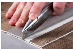
Vor dem Nahtschnitt (Doppelschnitt) auf die untere und obere Bahn im Schnittbereich ein glattes, gegenüber unserer Kaltschweißpaste und Temperatur beständiges Klebeband aufbringen. Die überlappend ausgelegten Belagsbahnen (3–5 cm) werden gleichzeitig in einem einzigen Schnitt entlang einer Metallschiene durchgeschnitten (Doppelschnittverfahren).
