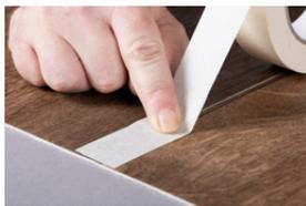
Ein gegenüber unserer Kaltschweißpaste und Temperatur beständiges, glattes Papierklebeband mittig auf die dicht geschnittene Naht kleben und fest auf den PVC-Bodenbelag anpressen, damit keine Kaltschweißpaste unter das Klebeband laufen und die Belagsoberfläche beschädigen kann.
