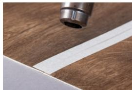
Bei wenig flexiblen PVC-Bodenbelägen (z. B. bei Objektbelägen) ermöglicht das Erwärmen des Nahtbereichs (max. 40 °C mittels Föhn oder Bügeleisen) vor der Verschweißung ein leichteres und gleichmäßigeres Führen der Düse Typ T in der Naht.
