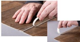
Nach dem Doppelschnitt sind die Schnittreste der oberen und der unteren Belagsbahn zu entfernen.
