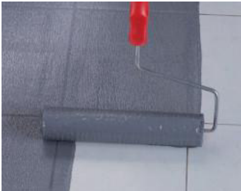
Auftragen von Eco Prim Grip Plus mit Rolle auf bestehenden keramischen Fliesen
