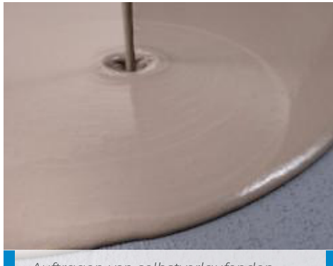
Auftragen von selbstverlaufenden Spachtelmassen auf trockener Eco Prim Grip Plus auf einem Altuntergrund
