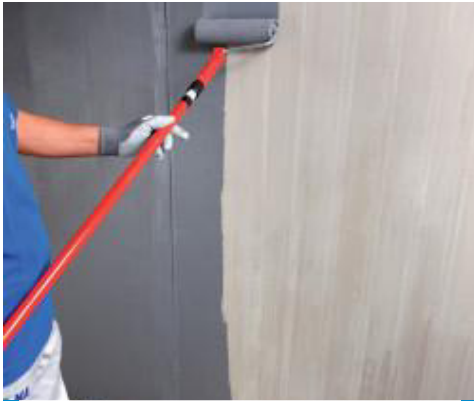
Auftragen von Eco Prim Grip Plus auf Beton mit Rolle
