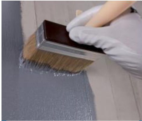
Auftragen von Eco Prim Grip Plus auf Beton mit Flächenstreicher
