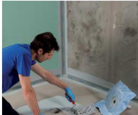
Einbau eines Bodenablaufs mit Mapegum WPS
