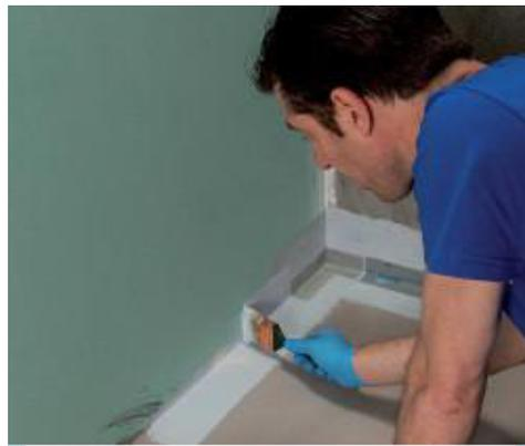
Einbau Mapeband PE 120 mit Mapegum WPS
