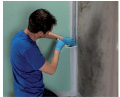
Einbau Mapeband PE 120 mit Mapegum WPS
