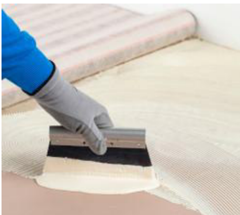
Auftrag von Ultrabond Eco TX2
