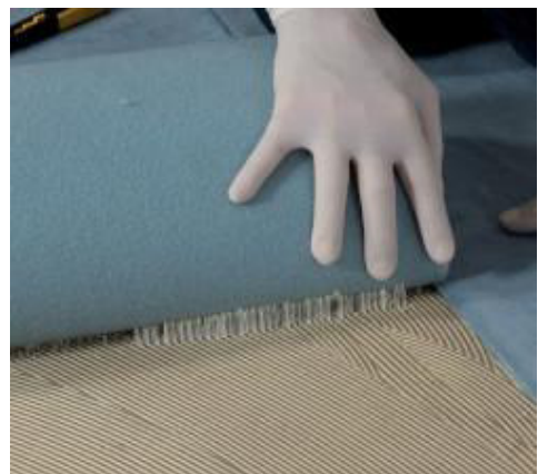
Verlegung von Nadelvlies
