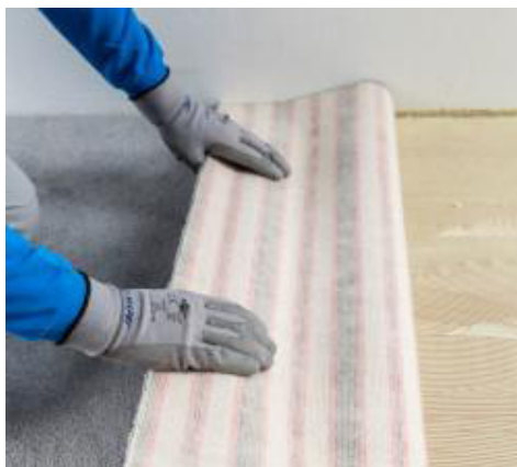
Verlegung von Tuftingbelag
