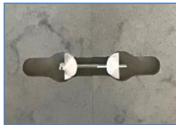
Abbildung 10: Arbeitsplattenverbinder
